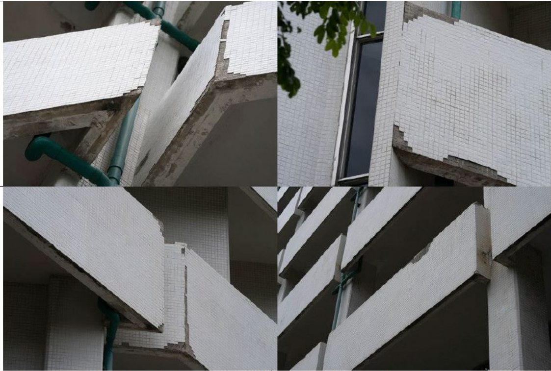
รูปที่ 1 แสดงกระเบื้องโมเสกเริ่มเสื่อมสภาพ แตกร้าว และหลุดร่วงลงมายังพื้นทางเดินด้านล่างที่อยู่รอบ ๆ อาคารมหาธีรราชานุสรณ์
